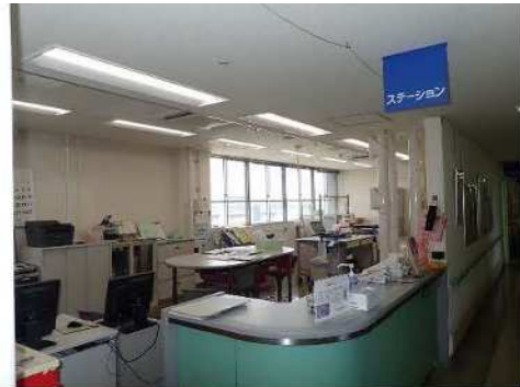
① ナースステーション LED（改修後）
