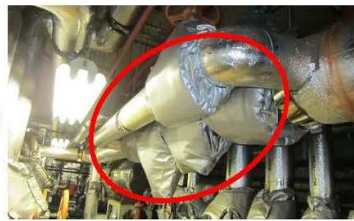
② 保温工事（改修後）
