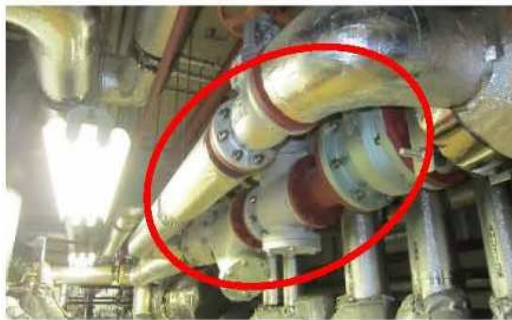
② 保温工事（改修前）
